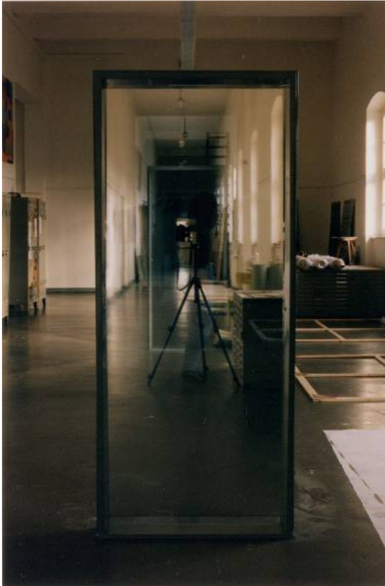
12. Probeaufbau der Türzargen.
